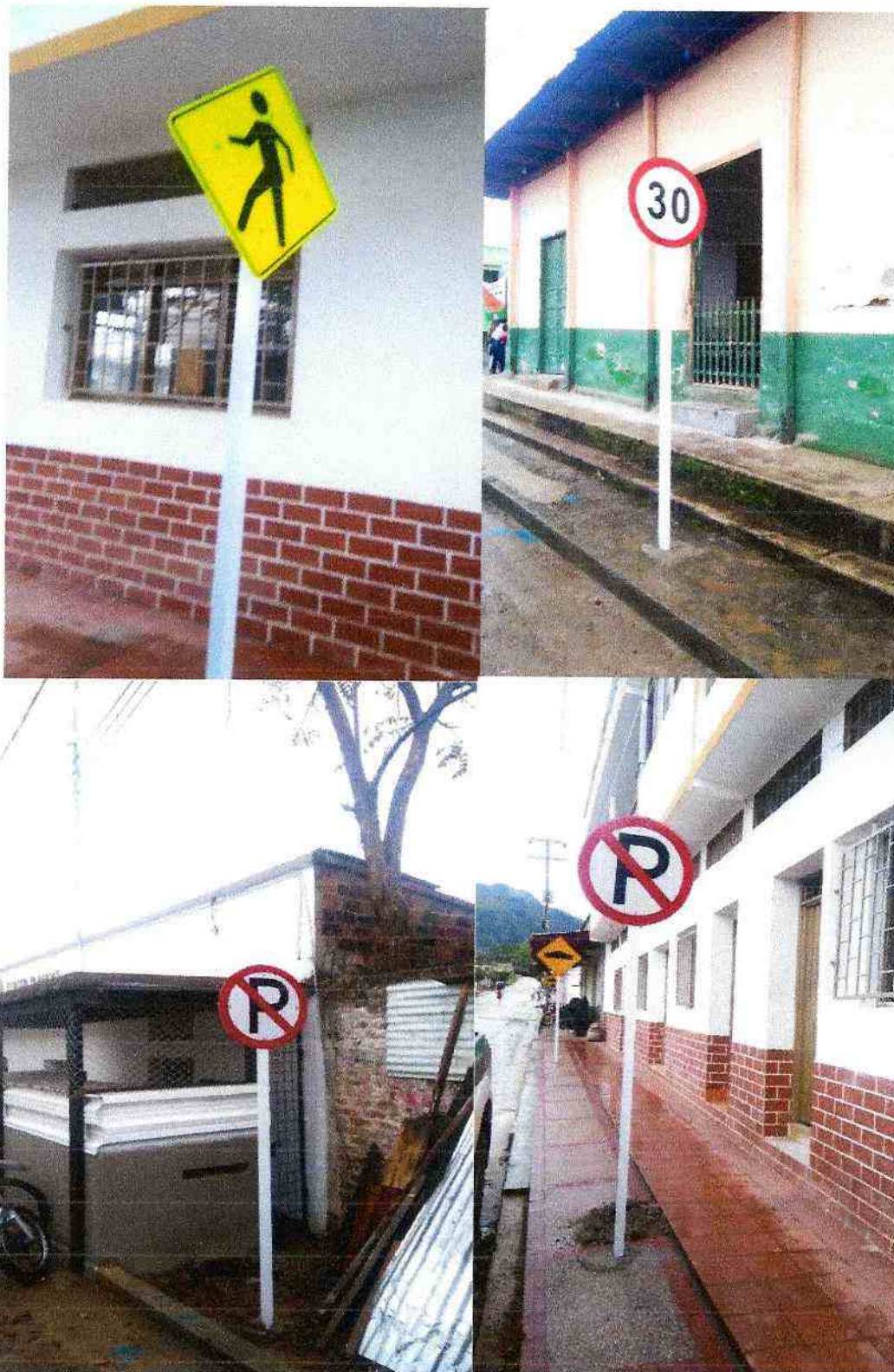
DETALLE FOTOGRAFICO 43: INSTALACIÓN DE SEÑALES PREVENTIVAS Y/O REGALMENTARIAS DE 60 CM UBICADAS EN LA CARRERA 5 ENTRE CALLES 5 Y 6 (ESTACION DE POLICIA).
