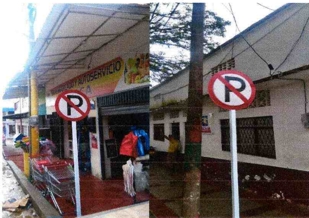
DETALLE FOTOGRAFICO 32: INSTALACIÓN DE SEÑALES PREVENTIVAS Y/O REGALMENTARIAS DE 60 CM UBICADAS EN LA CARRERA 5 ENTRE CALLES 6 Y 7.
