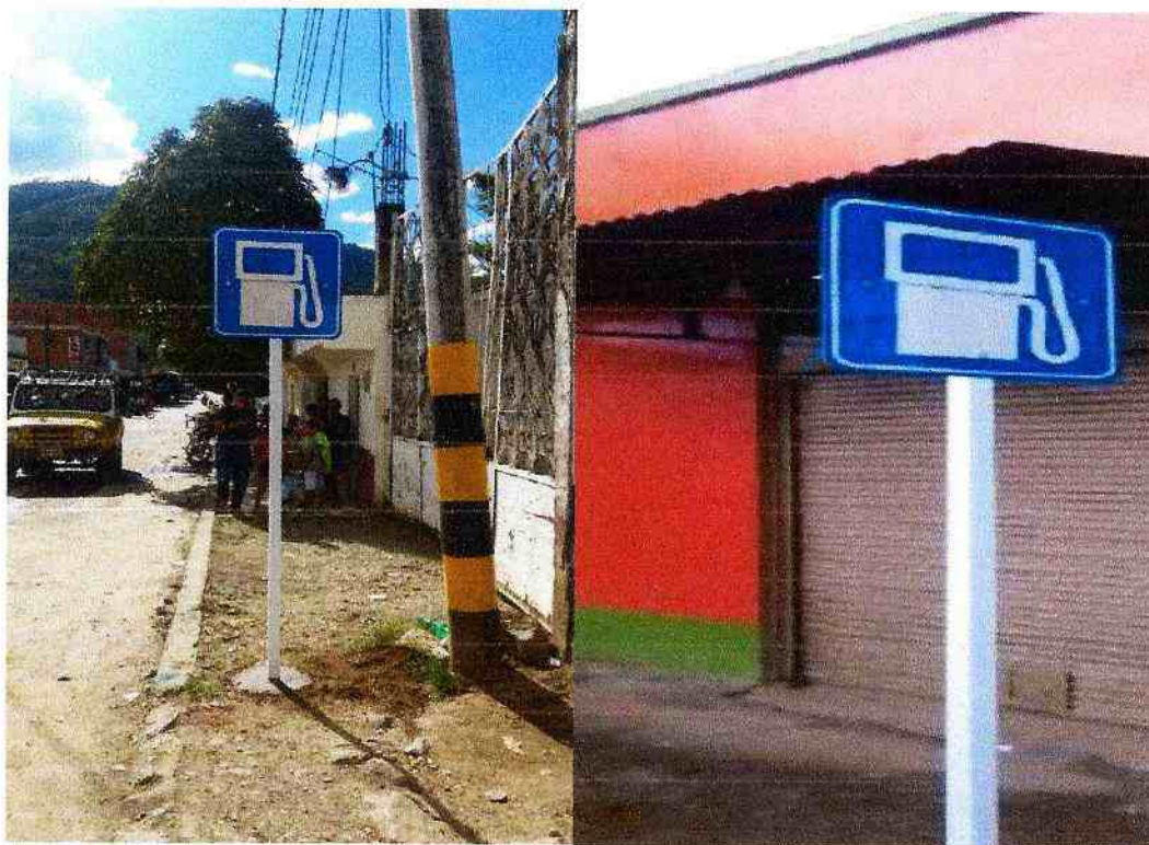
DETALLE FOTOGRAFICO 18: INSTALACIÓN DE SEÑALES PREVENTIVAS Y/O REGALMENTARIAS DE 60 CM UBICADAS EN LA CALLE 8 ENTRE CARRERAS 4 Y 5 (ESTACIÓN DE GASOLINA).
