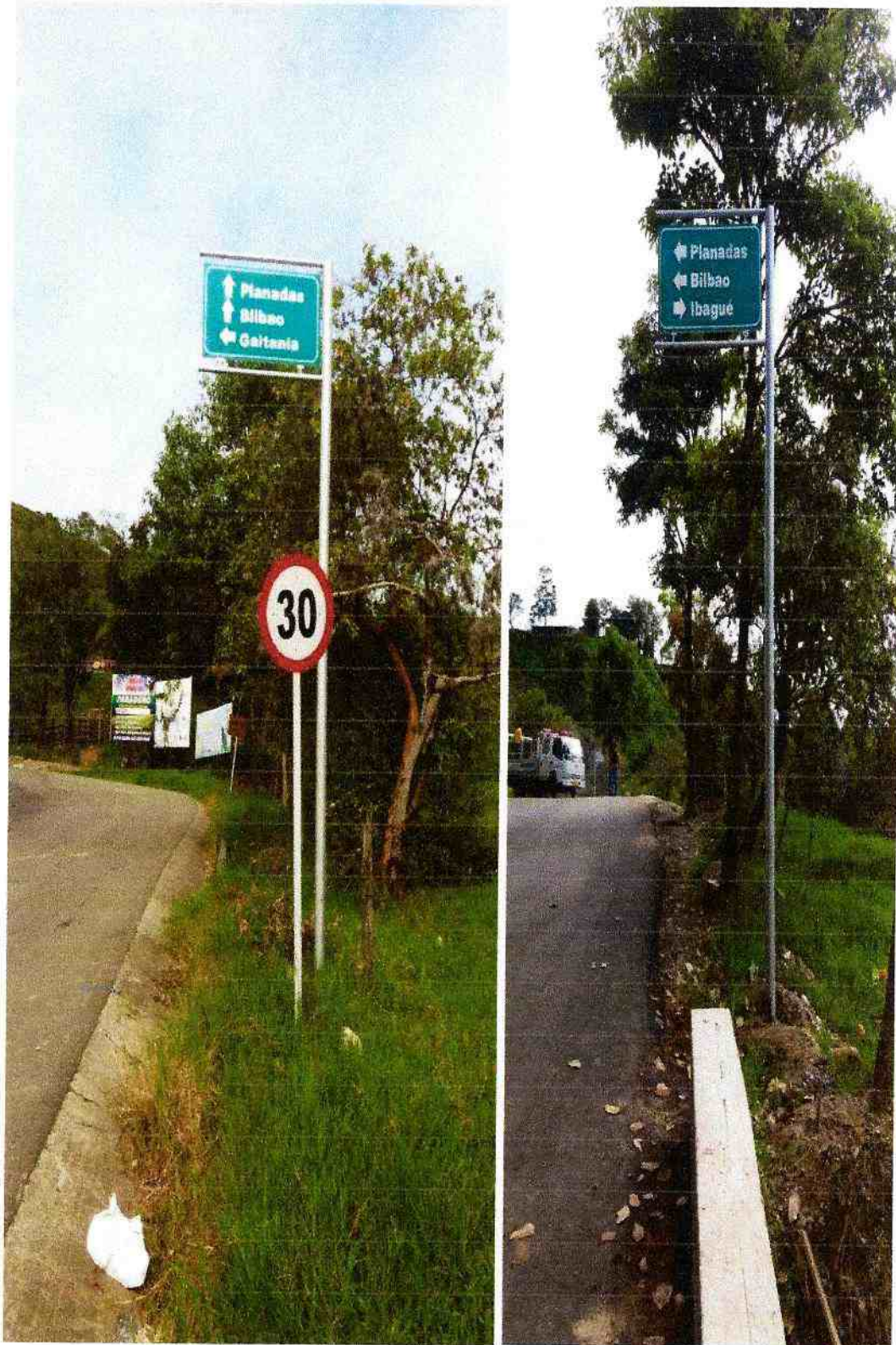
DETALLE FOTOGRAFICO 2: INSTALACIÓN DE SEÑALES INFORMATIVAS DE 1,30 mx 0,7 m en PR 0+00 Km. INTERSECCIÓN VIA GAITANIA Y PLANADAS.
