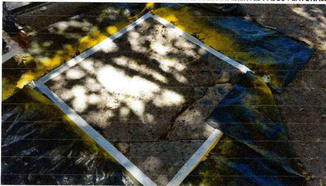
DETALLE FOTOGRAFICO 44: PINTURA DE PICTOGRAMAS PARA DIFERENTES PASOS PEATONALES.
