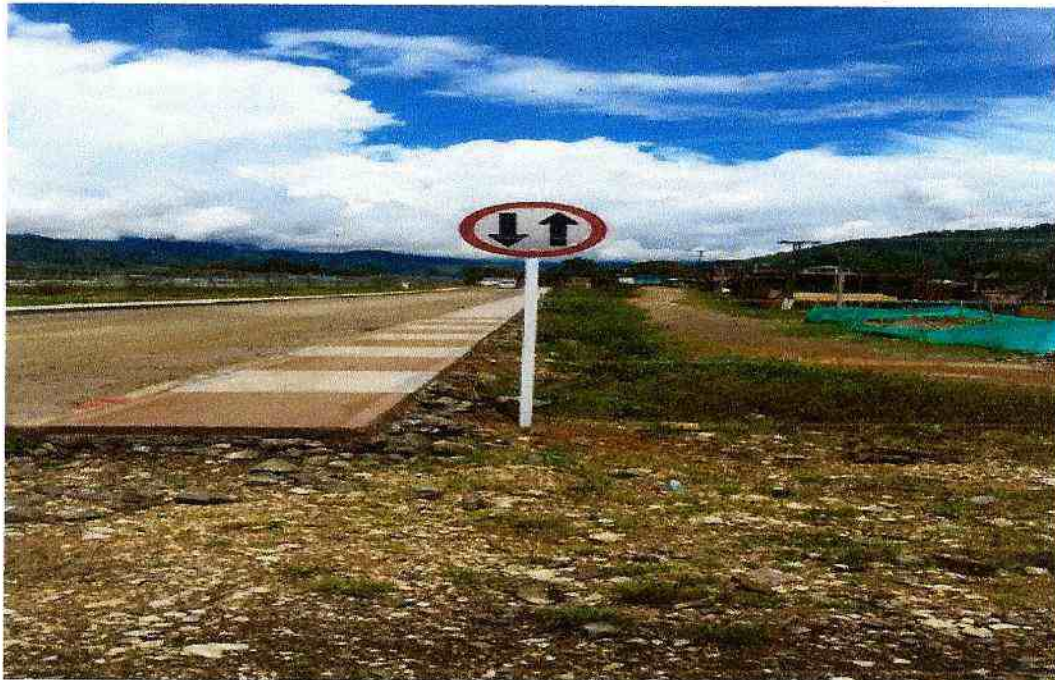
DETALLE FOTOGRAFICO 23: INSTALACIÓN DE SEÑALES PREVENTIVAS Y/O REGALMENTARIAS DE 60 CM UBICADAS EN LA TRANSVERSAL TERCERA (COLEGIO PABLO SEXTO).
