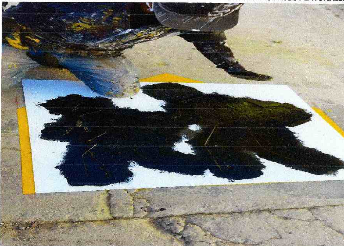
DETALLE FOTOGRAFICO 46: PINTURA DE PICTOGRAMAS PARA DIFERENTES PASOS PEATONALES.
