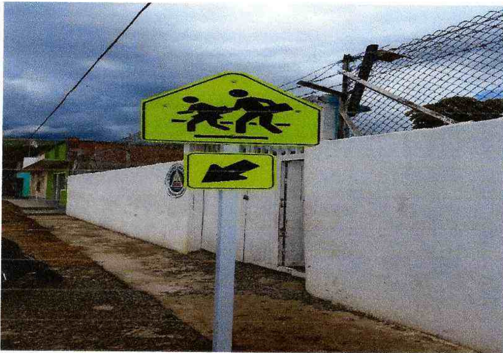
DETALLE FOTOGRAFICO 13: INSTALACIÓN DE SEÑALES PREVENTIVAS Y/O REGALMENTARIAS DE 60 CM UBICADAS EN LA CALLE 9 ENTRE CARRERAS 5 Y 6 (HOSPITAL).
