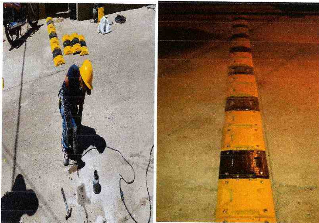
DETALLE FOTOGRAFICO 51: RESALTOS POLIPROPILENO CARRERA 5TA ENTRE CALLES 5TA Y 6TA (POLICIA).
