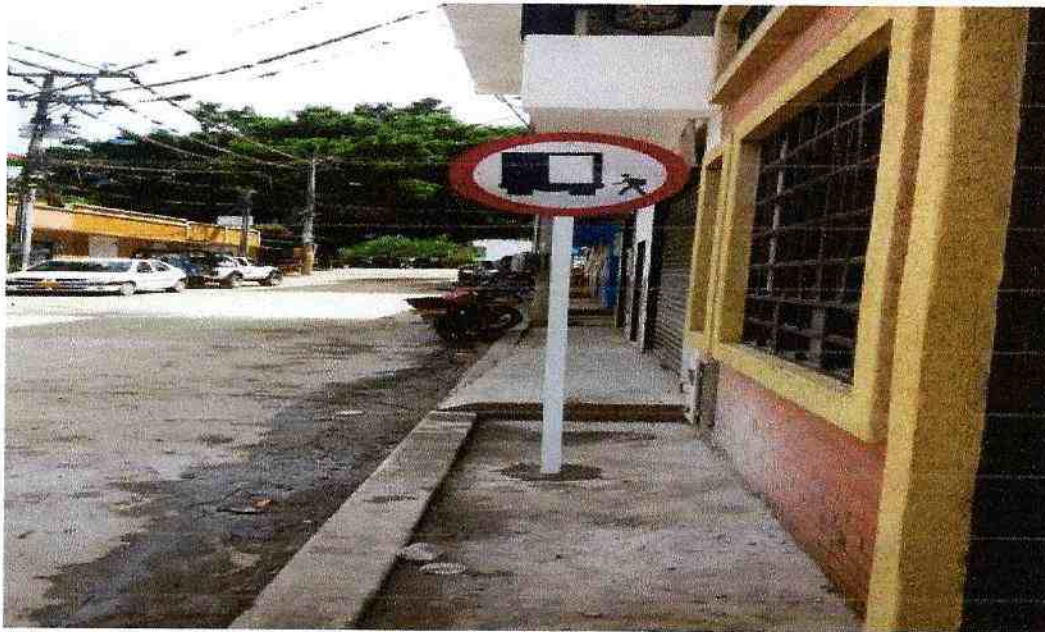
DETALLE FOTOGRAFICO 30: INSTALACIÓN DE SEÑALES PREVENTIVAS Y/O REGALMENTARIAS DE 60 CM UBICADAS EN LA CALLE 7 ENTRE LAS CARRERAS 4 Y 5.
