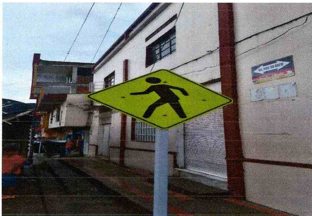
DETALLE FOTOGRAFICO 32: INSTALACIÓN DE SEÑALES PREVENTIVAS Y/O REGALMENTARIAS DE 60 CM UBICADAS EN LA CARRERA 5 ENTRE CALLES 6 Y 7.
