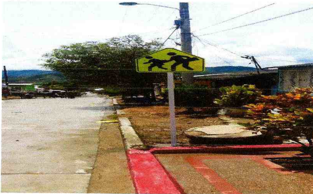
DETALLE FOTOGRAFICO 41: INSTALACIÓN DE SEÑALES PREVENTIVAS Y/O REGALMENTARIAS DE 60 CM UBICADAS EN LA CARRERA 5 ENTRE CALLES 5 Y 6 (ESTACION DE POLICIA).
