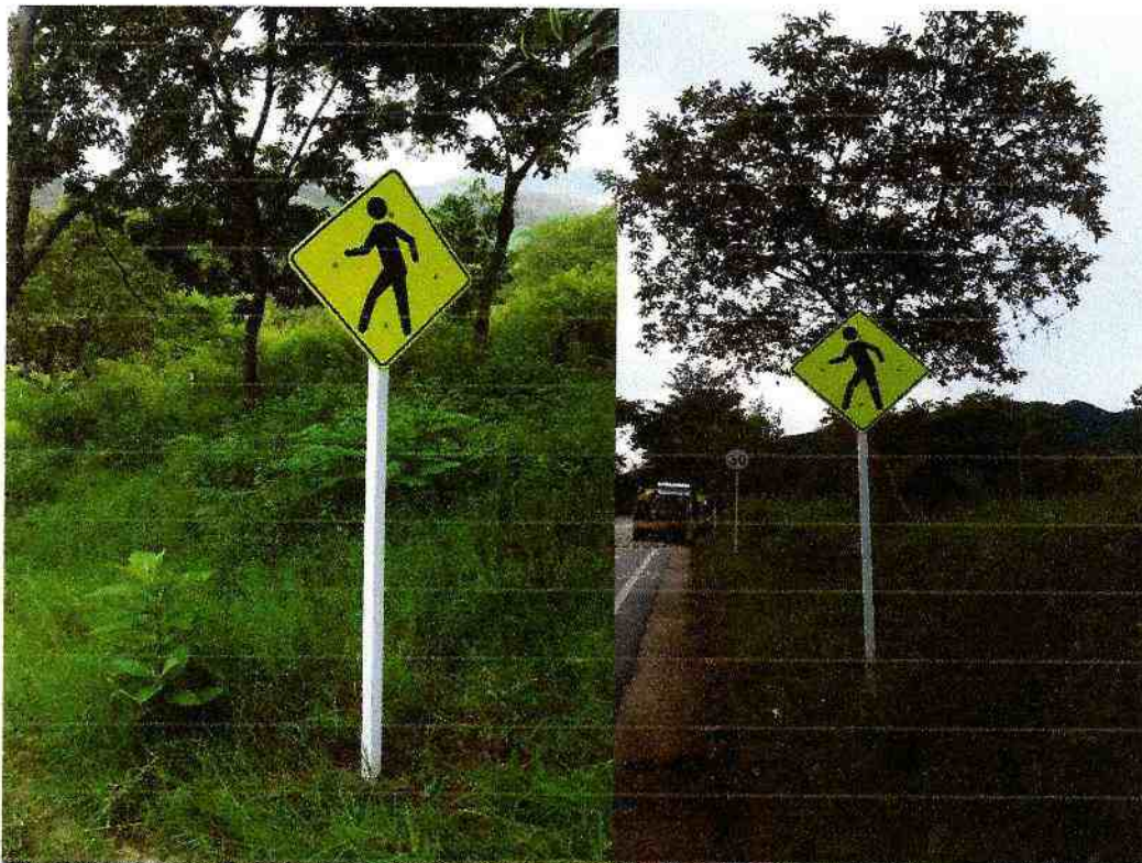
DETALLE FOTOGRAFICO 10: INSTALACION DE SEÑALES PREVENTIVAS Y/O REGALMENTARIAS DE 60 CM UBICADAS EN LA CARRERA 5 ENTRE LAS CALLES 8 Y 9 COLEGIO LA LIBERTAD.
