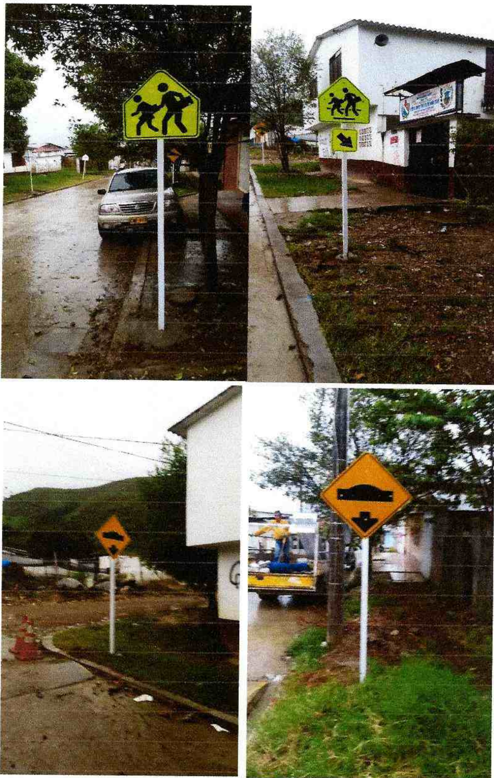
DETALLE FOTOGRAFICO 4: INSTALACIÓN DE SEÑALES PREVENTIVAS Y/O REGALMENTARIAS DE 60 CM UBICADAS EN LA CARRERA Y ENTRE CALLES 7 Y 8, COLEGIO DOMINGO SAVIO.
