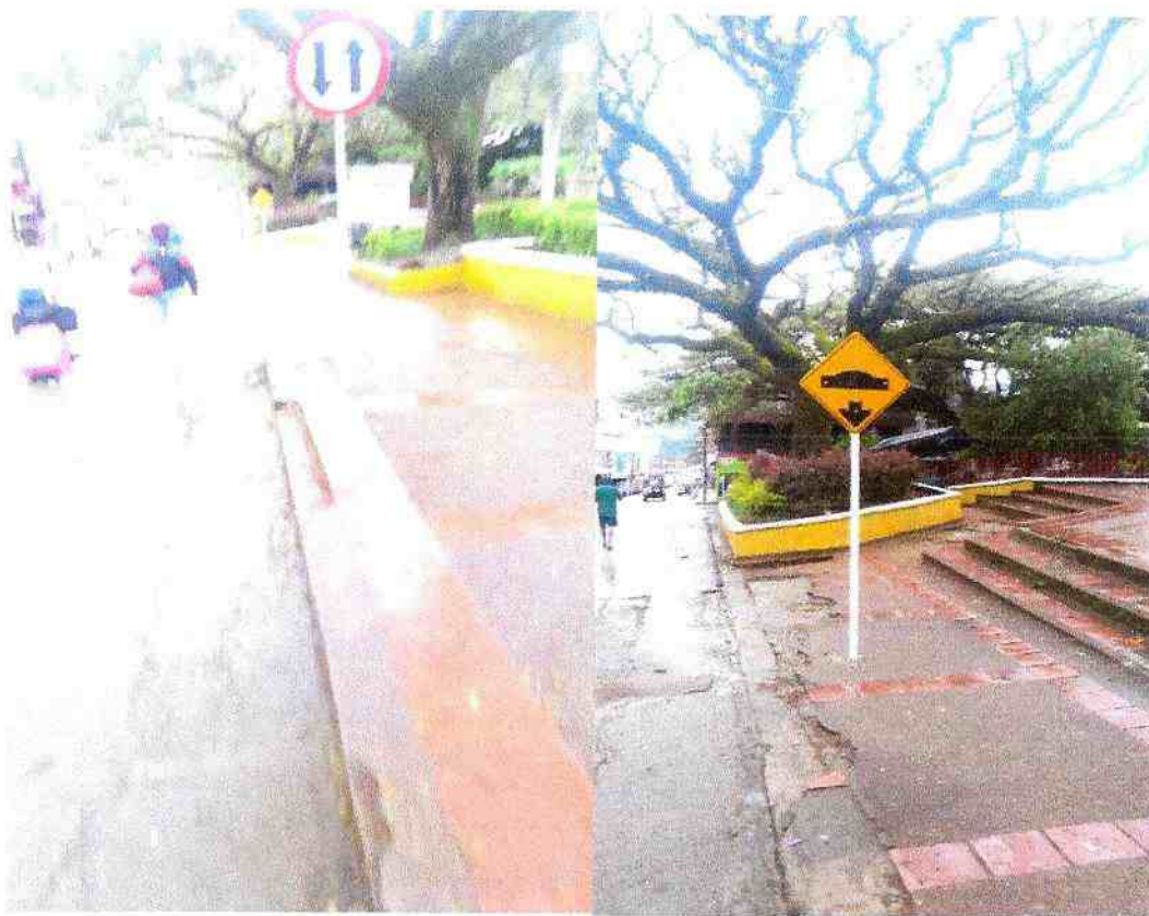
DETALLE FOTOGRAFICO 37: INSTALACIÓN DE SEÑALES PREVENTIVAS Y/O REGALMENTARIAS DE 60 CM UBICADAS EN LA CARRERA 6 ENTRE CALLES 6 Y 7.
