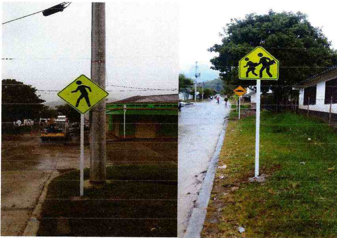
DETALLE FOTOGRAFICO 7: INSTALACIÓN DE SEÑALES PREVENTIVAS Y/O REGALMENTARIAS DE 60 CM UBICADAS EN EL KM 1 COLEGIO LOS ANDES.
