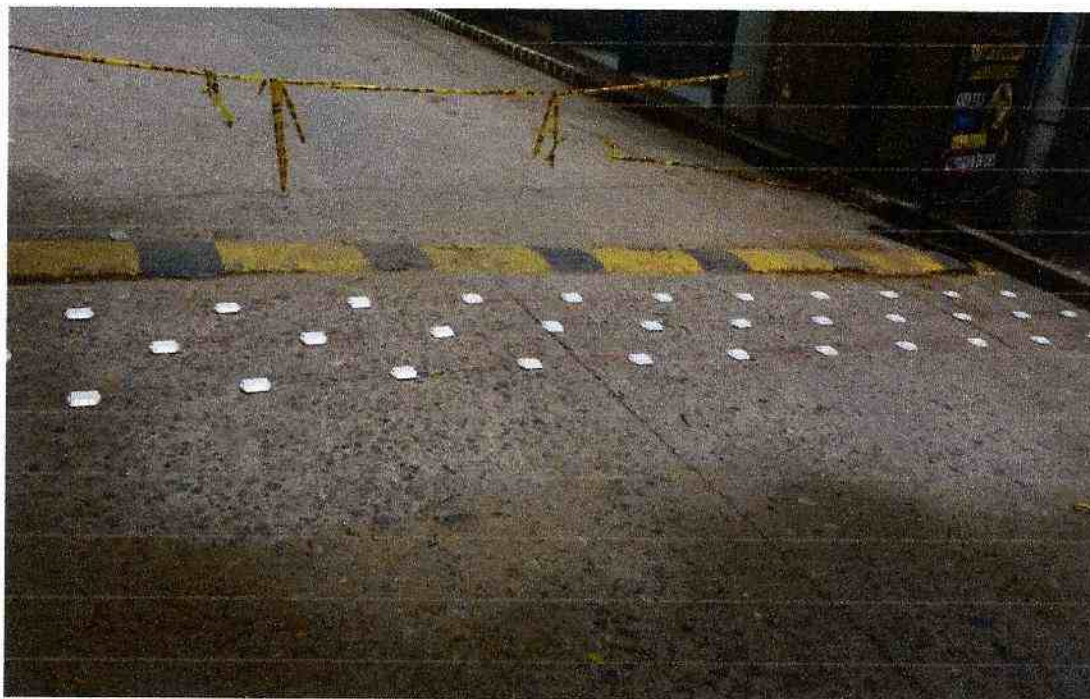
DETALLE FOTOGRAFICO 49: INSTALACIÓN TACHAS REFLECTIVAS CARRERA 6TA ENTRE CALLES 6TA Y 7MA.
