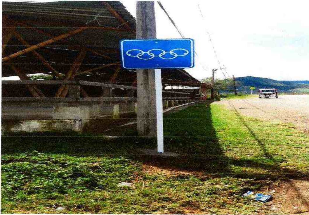
DETALLE FOTOGRAFICO 25: INSTALACIÓN DE SEÑALES PREVENTIVAS Y/O REGALMENTARIAS DE 60 CM UBICADAS EN LA CALLE 12 CON CARRERA 8 (ESCUELA SANTO DOMINGO SAVIO).
