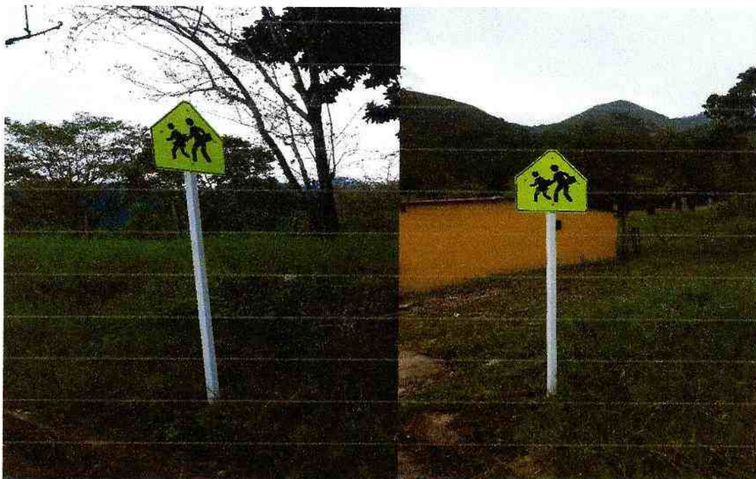
DETALLE FOTOGRAFICO 7: INSTALACIÓN DE SEÑALES PREVENTIVAS Y/O REGALMENTARIAS DE 60 CM UBICADAS EN EL KM 1 COLEGIO LOS ANDES.
