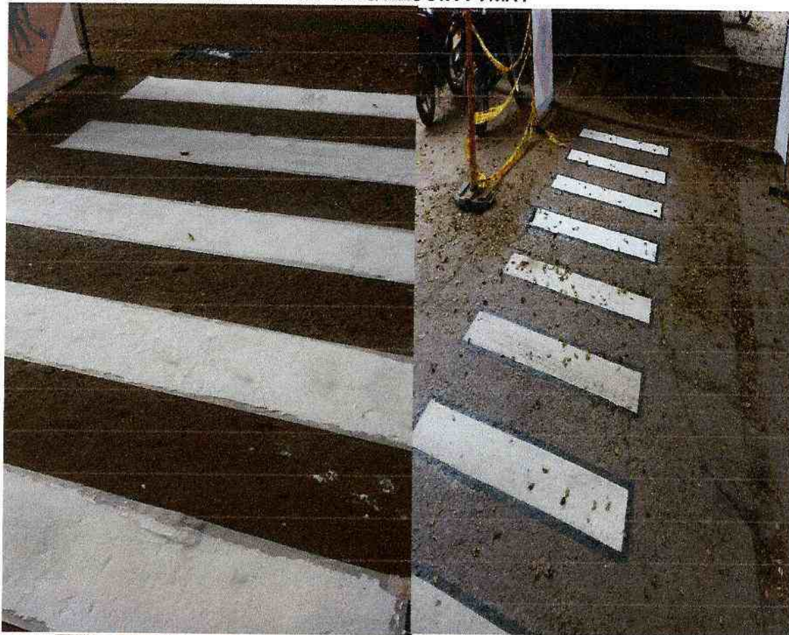
DETALLE FOTOGRAFICO 48: PINTURA DE PASO PEATONAL DOS COPONENTES EN FRIJO INCLUYE MICROESFERAS EN LA CARRERA 4TA ENTRE CALLES 6TA Y 7MA .
