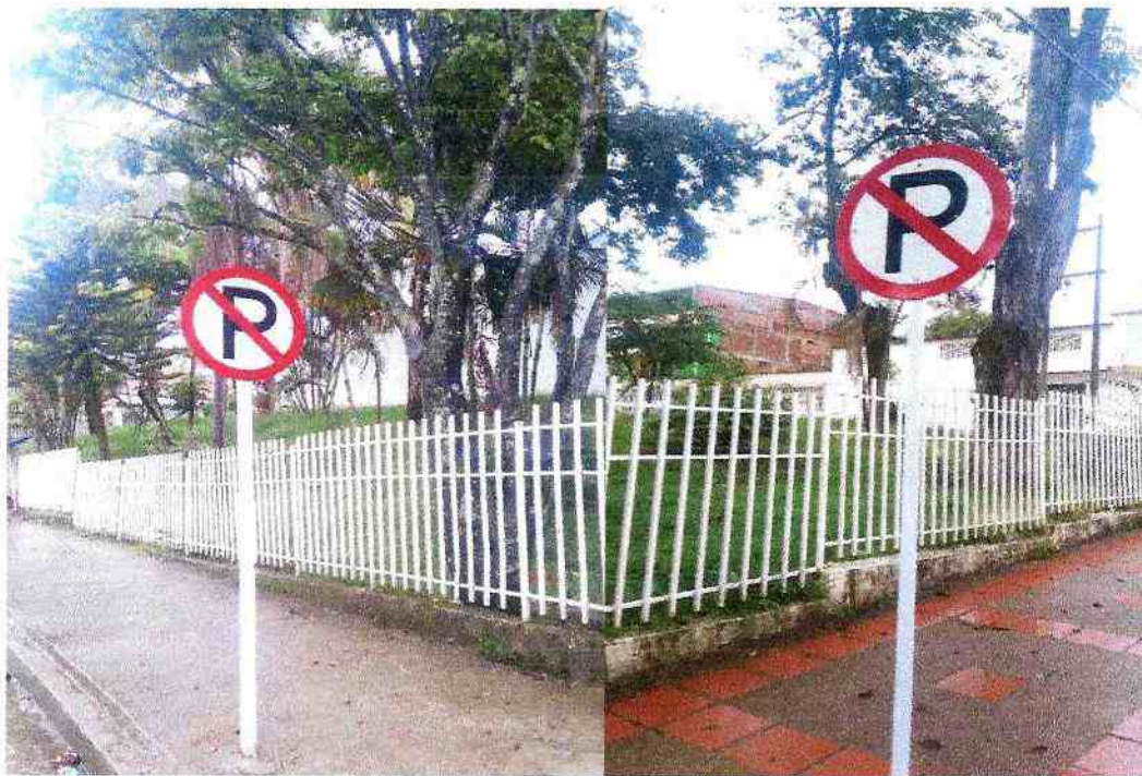
DETALLE FOTOGRAFICO 16: INSTALACIÓN DE SEÑALES PREVENTIVAS Y/O REGALMENTARIAS DE 60 CM UBICADAS EN LA CALLE 9 ENTRE CARRERAS 5 Y 6 (HOSPITAL).
