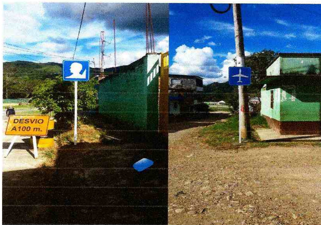
DETALLE FOTOGRAFICO 20: INSTALACIÓN DE SEÑALES PREVENTIVAS Y/O REGALMENTARIAS DE 60 CM UBICADAS EN LA CALLE 8 ENTRE CARRERAS 3 Y 4 (EJERCITO-AEROPUERTO).
