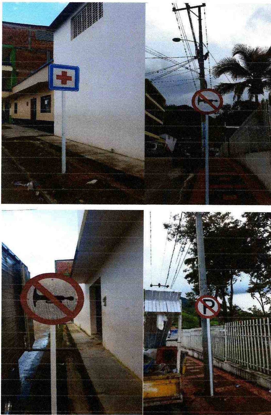
DETALLE FOTOGRAFICO 14: INSTALACIÓN DE SEÑALES PREVENTIVAS Y/O REGALMENTARIAS DE 60 CM UBICADAS EN LA CALLE 9 ENTRE CARRERAS 5 Y 6 (HOSPITAL).
