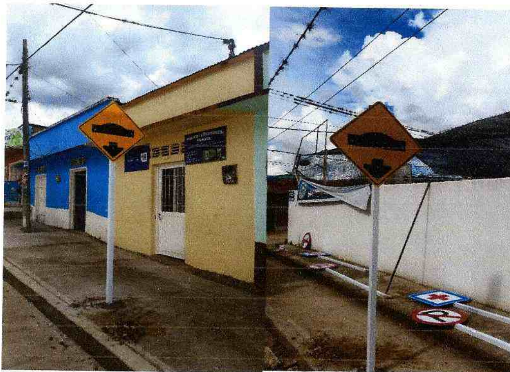
DETALLE FOTOGRAFICO 11: INSTALACIÓN DE SEÑALES PREVENTIVAS Y/O REGALMENTARIAS DE 60 CM UBICADAS EN LA CARRERA 5 ENTRE LAS CALLES 8 Y 9 COLEGIO LA LIBERTAD.
