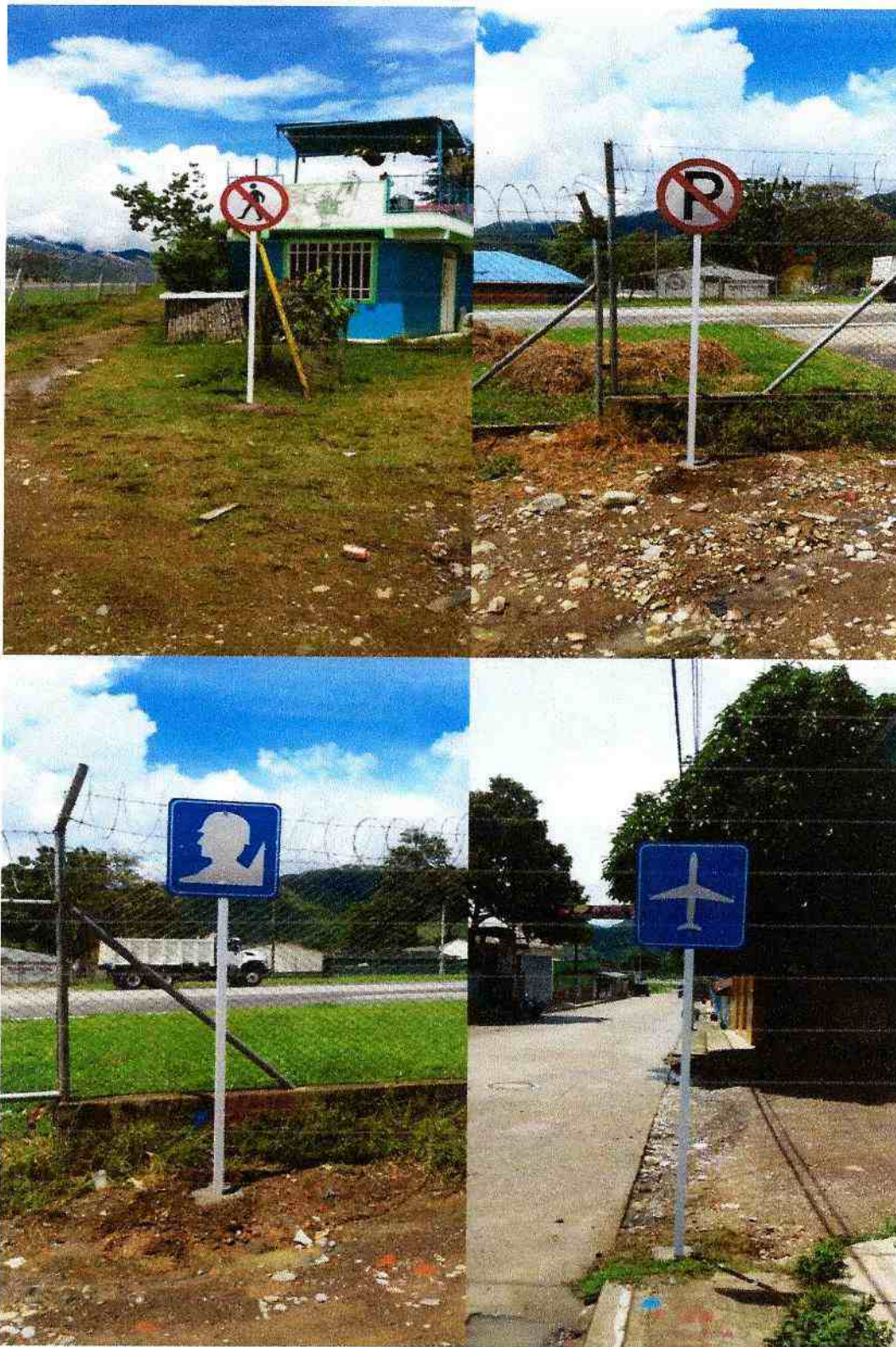
DETALLE FOTOGRAFICO 21: INSTALACIÓN DE SEÑALES PREVENTIVAS Y/O REGALMENTARIAS DE 60 CM UBICADAS EN LA TRANSVERSAL TERCERA (EJERCITO-AEROPUERTO).
