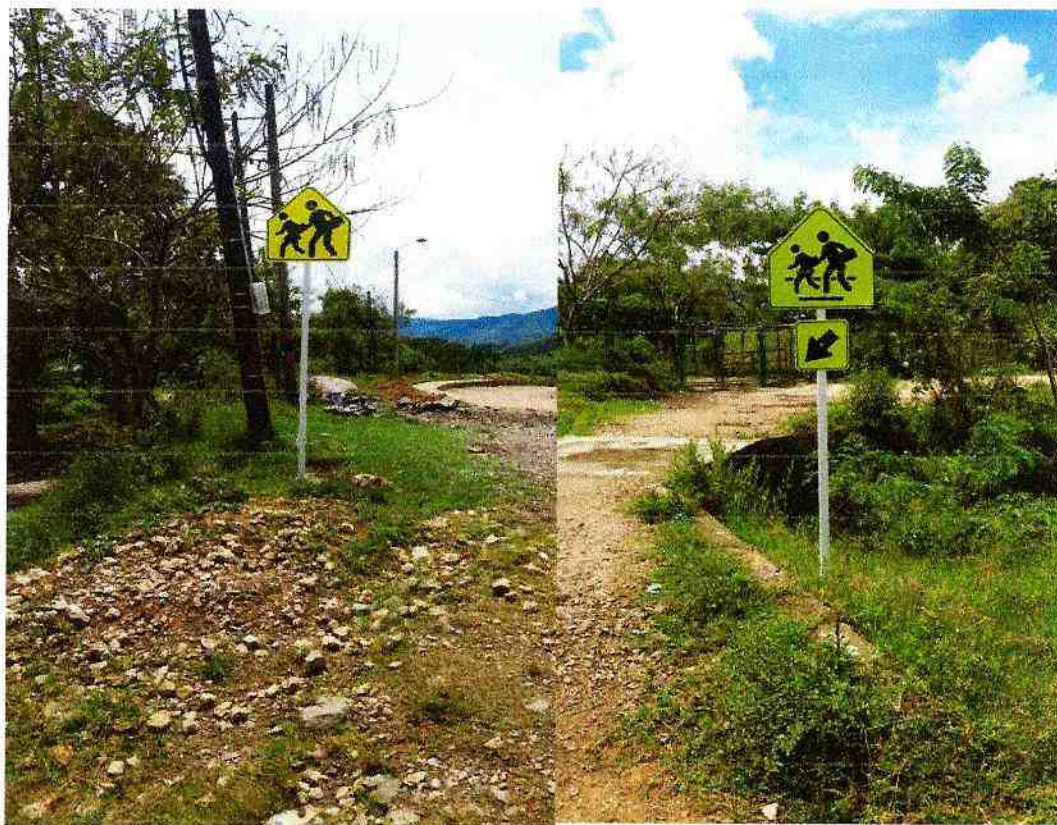
DETALLE FOTOGRAFICO 23: INSTALACIÓN DE SEÑALES PREVENTIVAS Y/O REGALMENTARIAS DE 60 CM UBICADAS EN LA TRANSVERSAL TERCERA (COLEGIO PABLO SEXTO).
