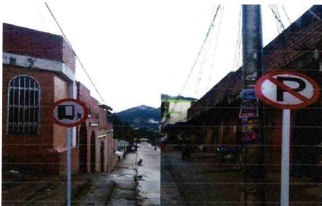
DETALLE FOTOGRAFICO 17: INSTALACIÓN DE SEÑALES PREVENTIVAS Y/O REGALMENTARIAS DE 60 CM UBICADAS EN LA CALLE 8 ENTRE CARRERAS 5 Y 6 (GALERIA DE MERCADO).
