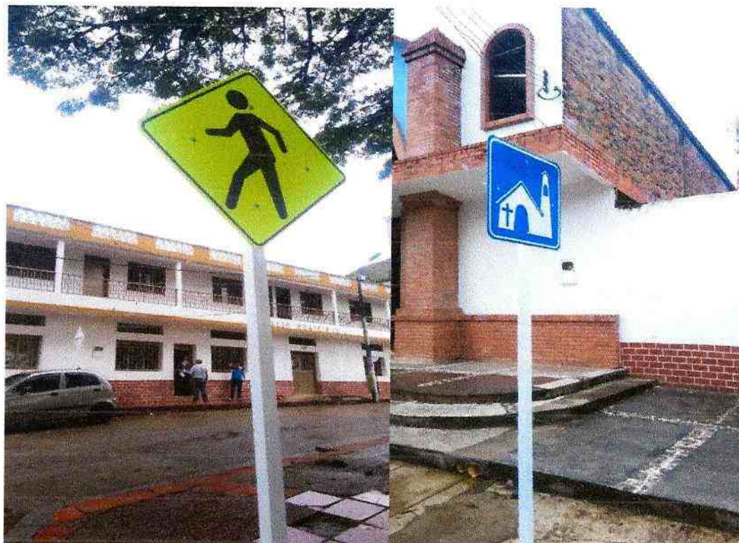
DETALLE FOTOGRAFICO 35: INSTALACIÓN DE SEÑALES PREVENTIVAS Y/O REGALMENTARIAS DE 60 CM UBICADAS EN LA CALLE 6 ENTRE CARRERAS 6 Y 7.
