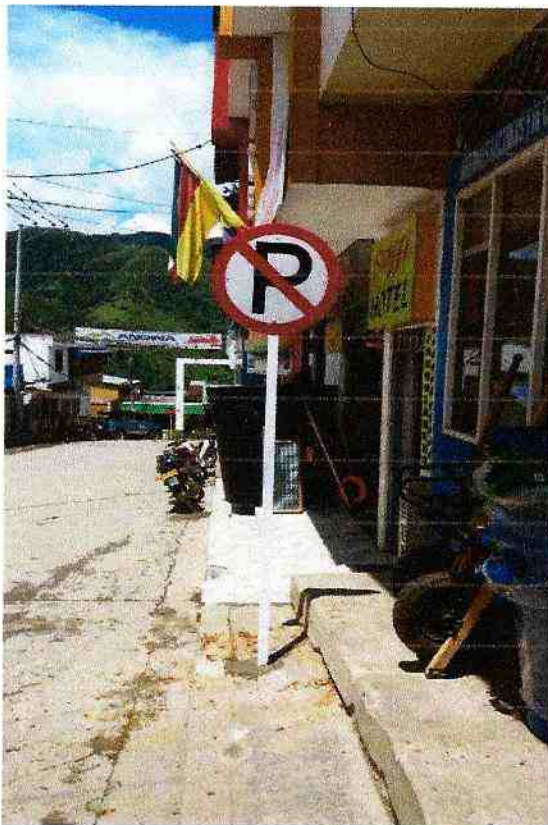
DETALLE FOTOGRAFICO 30: INSTALACIÓN DE SEÑALES PREVENTIVAS Y/O REGALMENTARIAS DE 60 CM UBICADAS EN LA CALLE 7 ENTRE LAS CARRERAS 4 Y 5.
