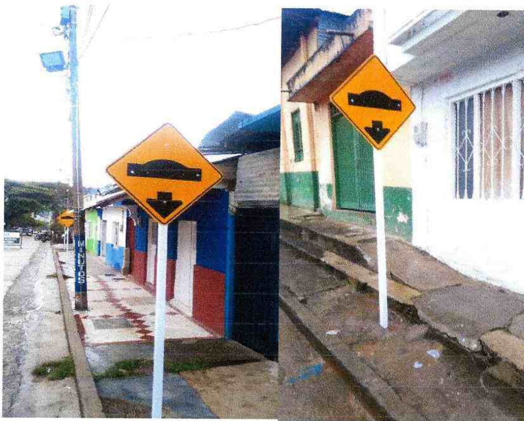
DETALLE FOTOGRAFICO 41: INSTALACIÓN DE SEÑALES PREVENTIVAS Y/O REGALMENTARIAS DE 60 CM UBICADAS EN LA CARRERA 5 ENTRE CALLES 5 Y 6 (ESTACION DE POLICIA).
